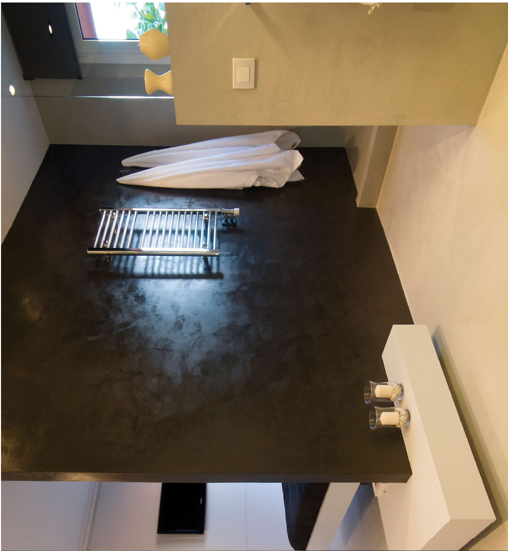
Walls coated in negro fumo and sabbia Microcemento®. Floor and shower tray covered in Bakatel®. Paredes revestidas en Microcemento® negro fumo y sabbia. Suelo y plato de ducha revestidos en Bakatel® gris perla.
